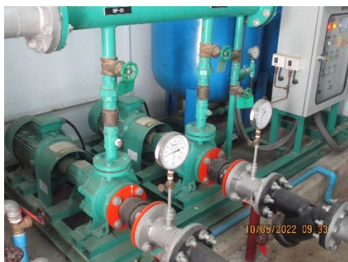
รูปที่ 3-4 การตรวจสอบการทำงานของปั้มน้ำชั้นดาดฟ้า และชั้นใต้ดิน
