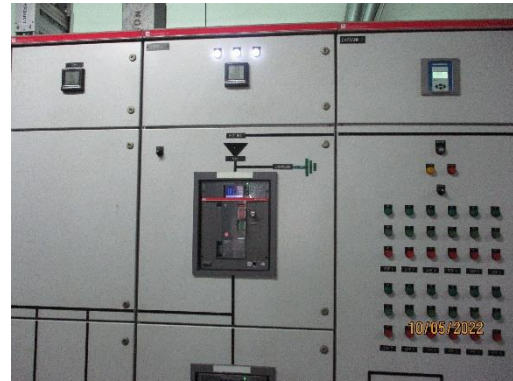
รูปที่ 3-8 ตู้ Main Distribution Board
