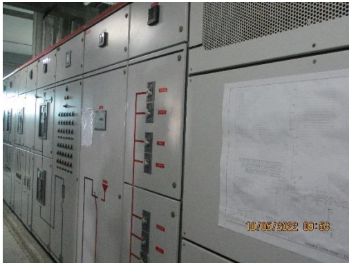
รูปที่ 3-8 ตู้ Main Distribution Board
