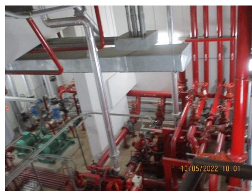
รูปที่ 3-11 การตรวจสอบอุปกรณ์สำหรับแจ้งเตือนภัย และอุปกรณ์สำหรับป้องกันอัคคีภัย
